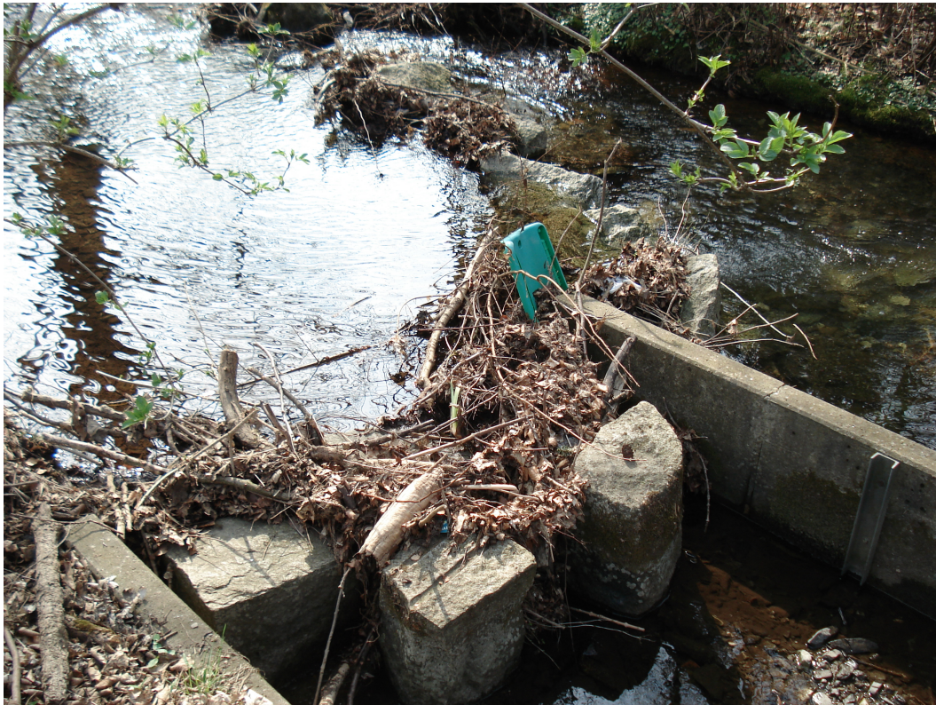
Abbildung 2.6: Verstopfung einer FAA im Zillierbach durch Treibholz und Unrat.
