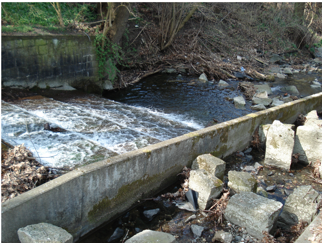
Abbildung 6.7: Ein durch Treibgutverstopfung und Niedrigwasser weitgehend trockengefallener Rauherinne-Beckenpass im Zillierbach (Z4), der seine Funktionsfähigkeit temporär eingebüßt hat.
