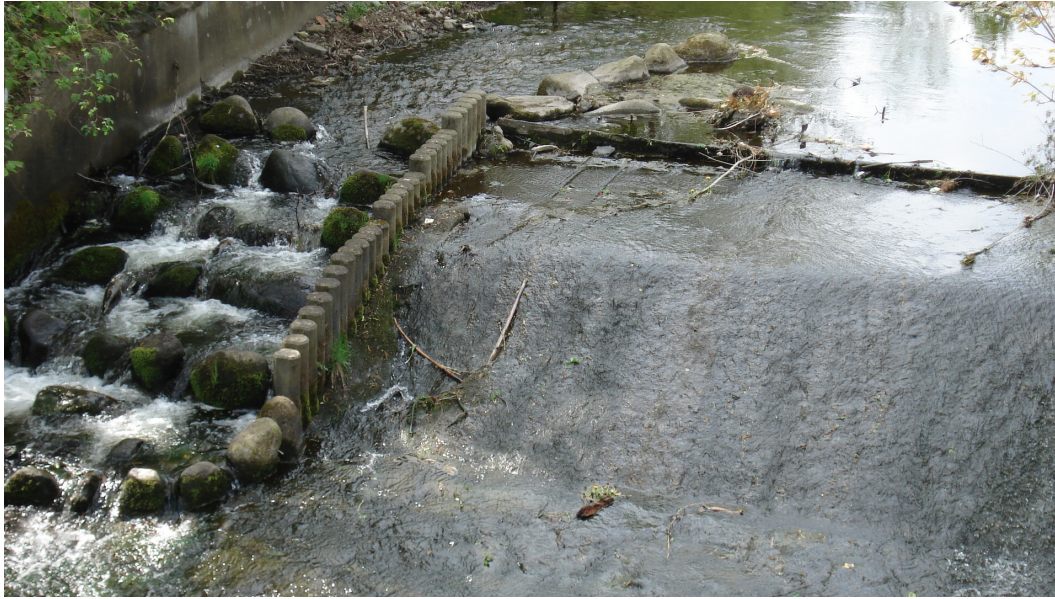
Abbildung 2.4: Der Rauherinne-Beckenpass Holtemme H6 (auf der linken Seite, auf der rechten Seite ist das ursprüngliche Querbauwerk erhalten geblieben).
