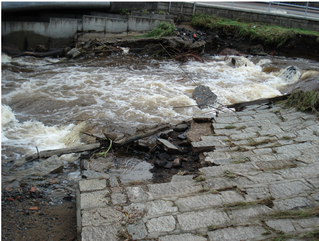
Abbildung 4.1: Die Reste des im Juli 2017 durch ein Hochwasserereignis fast vollständig zum Einsturz gebrachten Querbauwerks H4 in der Holtemme. Im Hintergrund ist der Einstieg in die weitgehend unbeschädigt gebliebene FAA zu sehen, die durch den Wegfall des Querbauwerks vorübergehend obsolet gemacht wurde.
