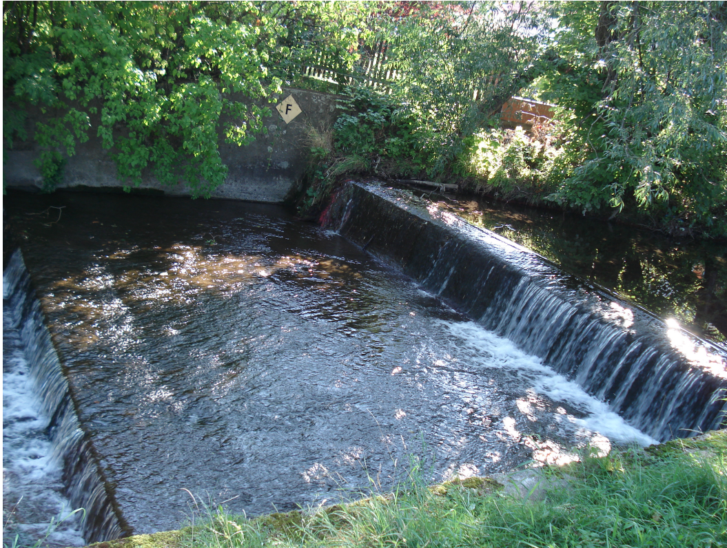
Abbildung 2.1: Für Bachforellen und andere Fischarten unüberwindbares Querbauwerk in der Holtemme im Jahr 2011, das inzwischen vollständig rückgebaut wurde.
